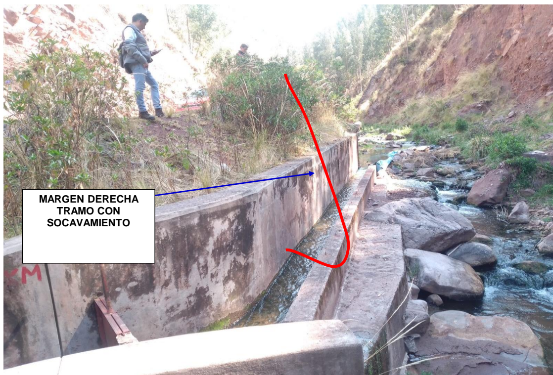
FIGURA N°03: EN LA TEMPORADA DE MAXIMAS AVENIDAS, AFECTA A LA BOCATOMA INCACONA CON SOCAVAMIENTO POR LA MARGEN DERECHA Y DE IGUAL FORMA SU TALUD ESTA DEBILITADO DE CAUCE MAS ARRIBA DE BOCATOMA
